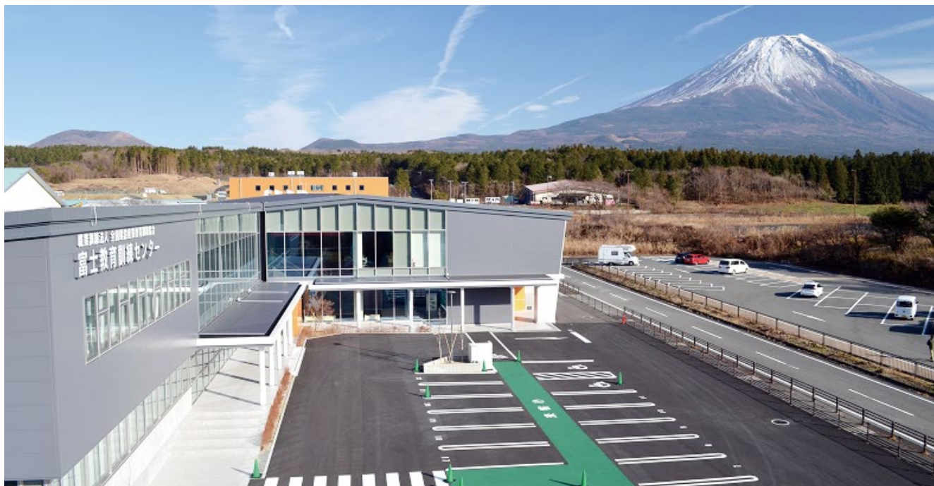
新本館・教室棟が完成した富士教育訓練センター (写真提供 同センター)
