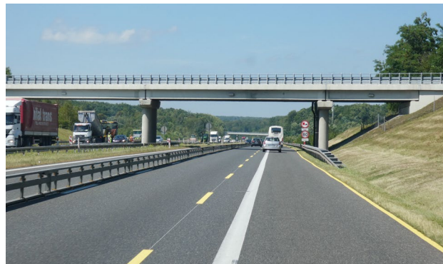
工事中で車線が狭くなっている高速道路
