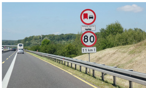
工事中だけの道路標識
