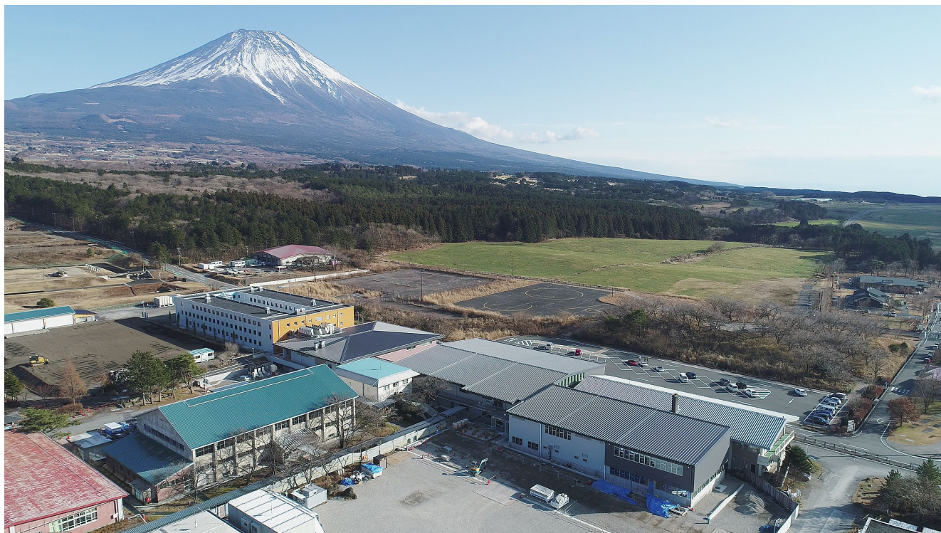
新本館・教室棟が完成間近の富士教育訓練センター
