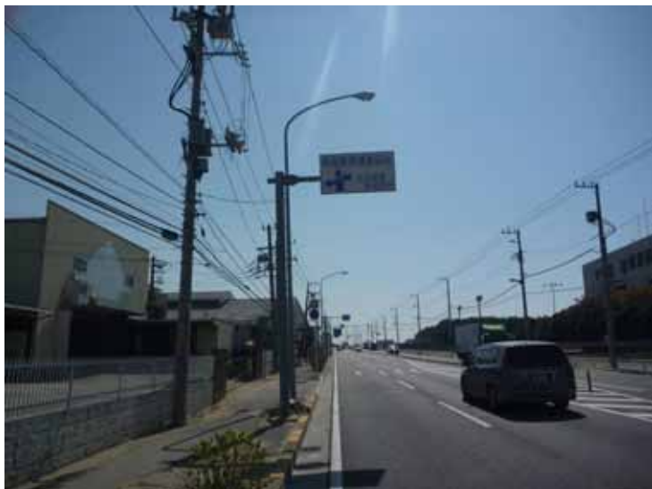
千葉県千葉市美浜区 (標識柱+基礎不明)2°傾斜
